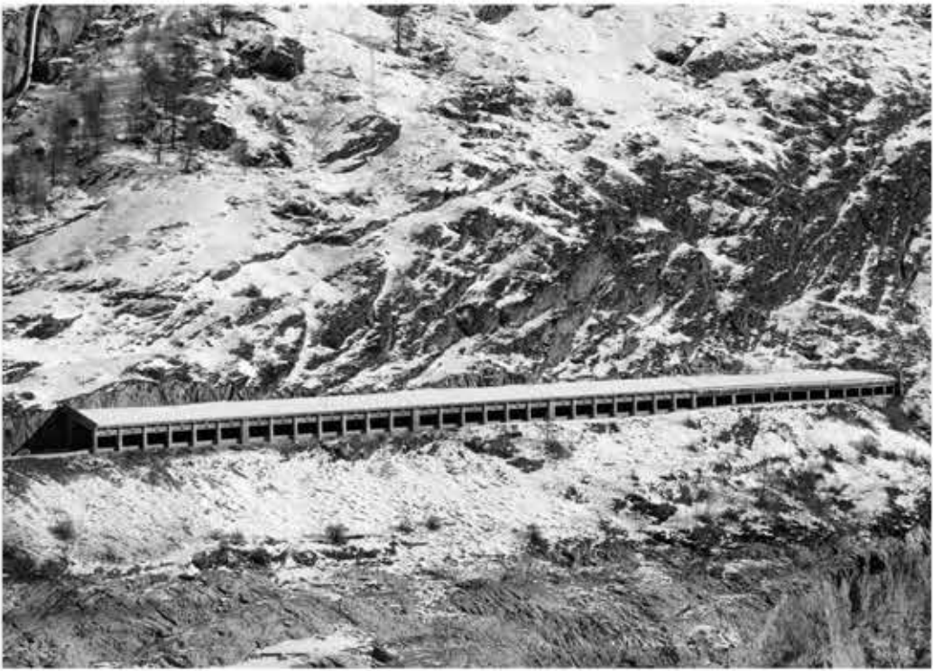
Tunnel paravalanche, Tignes © Photothèque IRMa
