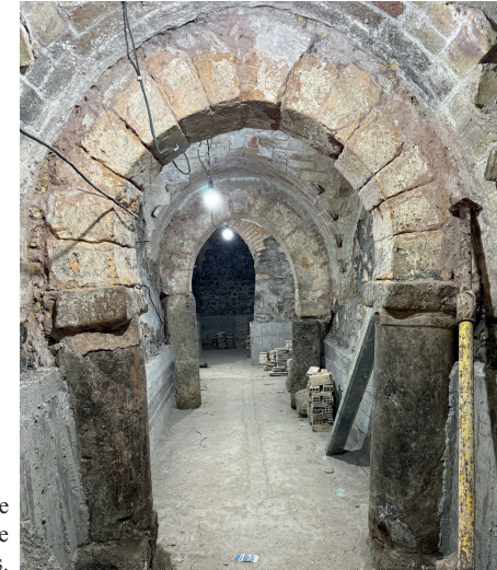
Dans la cave de Dār Ennaifer, la voûte est soutenue par des arcs en pierre soutenus par de massives colonnes.
