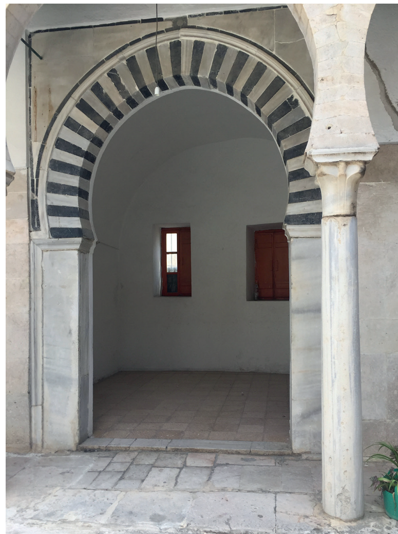
Vue de l'iwān est de la medersa el-Chammāiya. Encadré par un arc outrepassé aux clavaux alternés de marbre noir et blanc, typique de l'architecture hafside.
