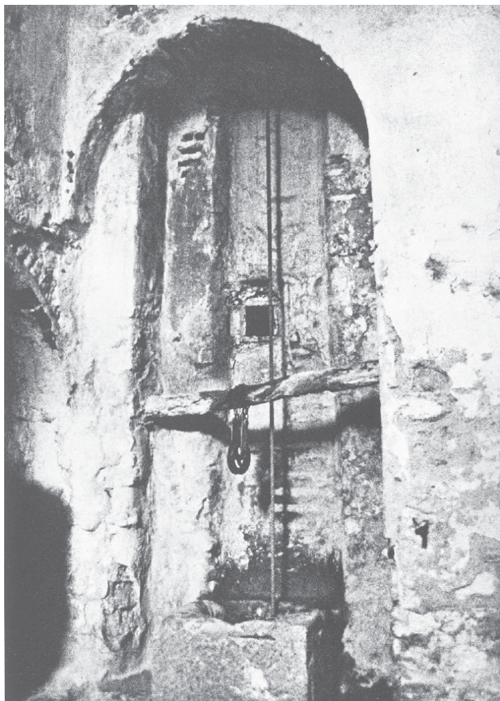
Le puits de Dār El-Haddād est aménagé dans une niche faisant office de gaine et permettant le puisage de l'eau depuis le premier étage.
