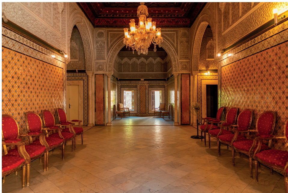
La salle d'apparat, au fond du patio, bīt ras eddār , se caractérise par un plan cruciforme avec des chambrettes, maqsūras latérales. Les parties inférieures des murs sont revêtus de carreaux de faïence au motif dit "patte de lion" tandis que les parties supérieures sont revêtues de stucs finement ciselés. Le plafond est en bois peint d'inspiration italienne. Au fond du défoncement médian, deux fenêtres s'ouvrent sur une cour-jardin en contrebas.
