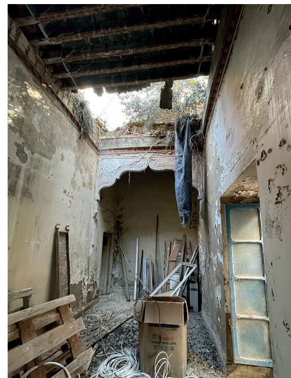
Chambre en T du rez-de-chaussée de Dār Hababou dont les plafonds sont partiellement effondrés.
