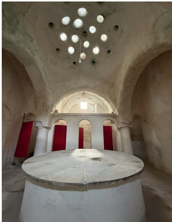
Salle de lavage ou bīt el-ghasīl de hammām el-Tammārīn, couverte d'une coupole perforée de hublots. En avant-plan, l'estrade centrale de lavage et au fond, 4 matharas , cabines de lavage privatives.
