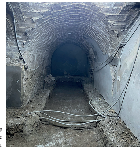
Dans la cave de Dār Bouthour, la couverture des trois ailes est une voûte en berceau en briques.
