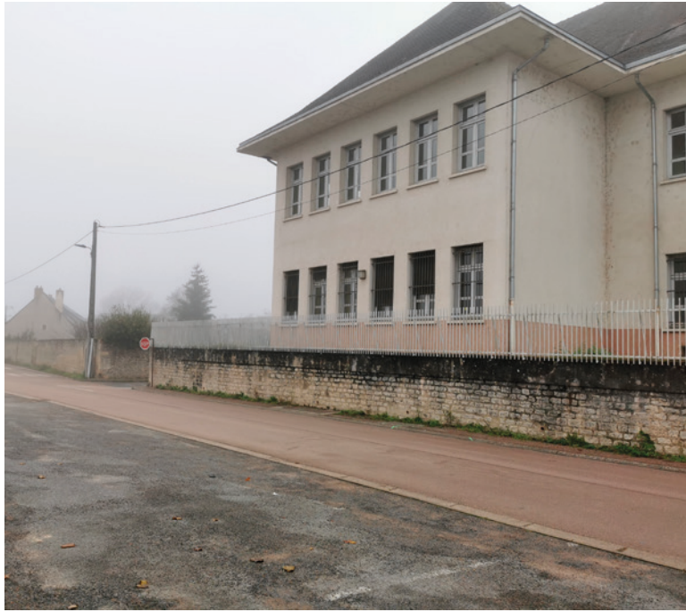
img. 8 : Bâtiment d'usine désaffecté, Decize, Nièvre ©Chloé Schindler
