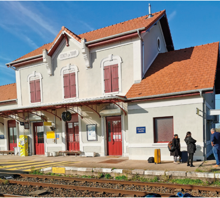
img. 20 : Gare de Cercy-la-Tour, Nièvre ©Chloé Schindler
