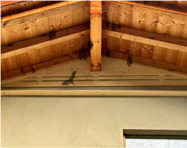
Fig. 70: Mise en place d'une planche sous la colonie pour éviter la chute du guano
