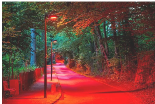
Fig. 64 : A Lille, l'éclairage près des boisements fut adapté pour les chauves-souris qui utilisent cette zone pour chasser. Les lampadaires ne sont dirigés que sur le passage piéton, limitant un halo lumineux dérangeant pour la faune. Le choix de lampes à sodium attire moins les insectes, et la couleur rouge est relativement bien supportée par les chiroptères.
