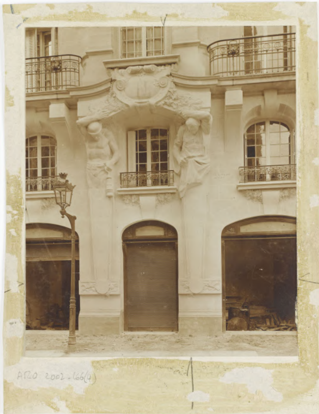
Détail de deux atlantes, à la fin du chantier
