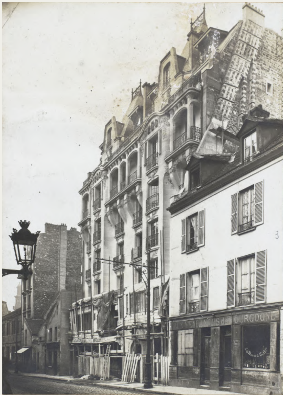
Immeuble à la fin du chantier.
