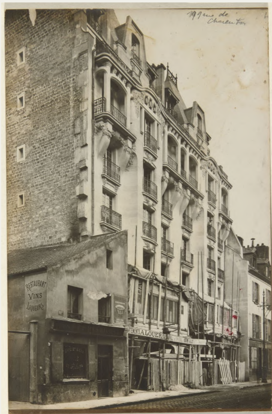
Immeuble à la fin du chantier
