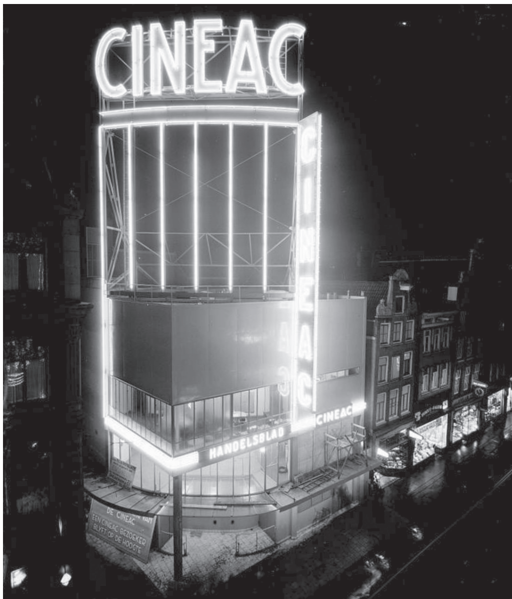
Fig. 12 Photo de la façade de nuit, 1934
