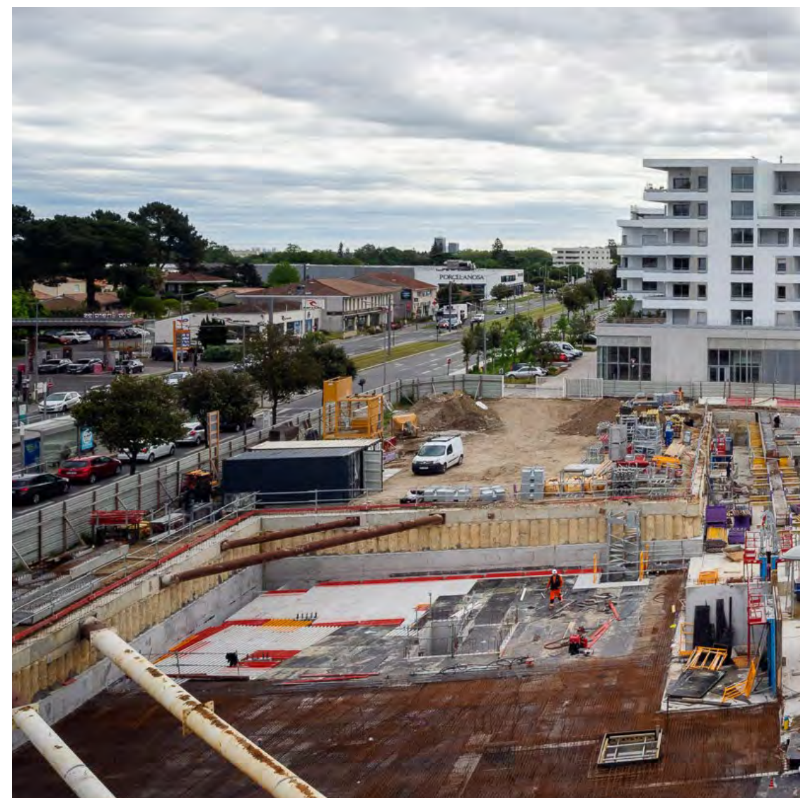
Chantier du projet Edonia à Mérignac © Sabine Delcour
