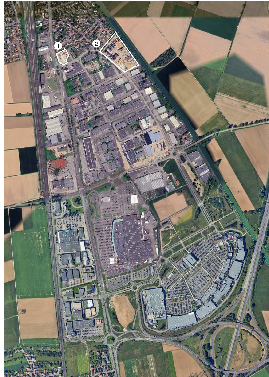
Photo aérienne après leurs transformations 1:10'000 © Google Earth 2024
