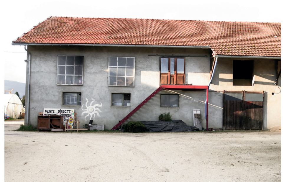
Le bâtiment de stockage vu depuis la cour
