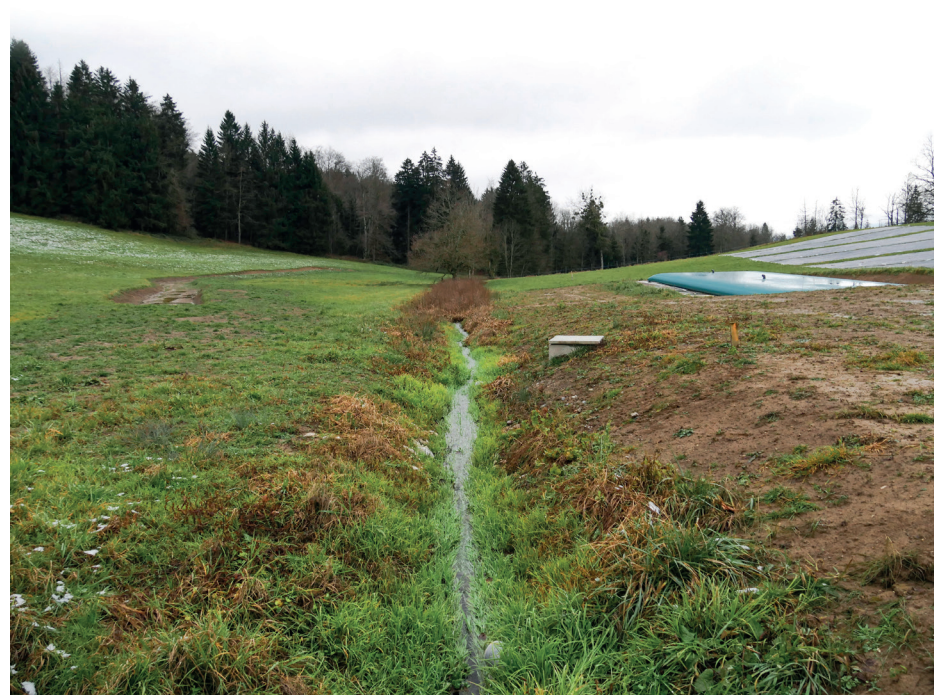
De gauche à droite : le bassin de rétention, le ruisseau, la citerne souple de 200 m³
