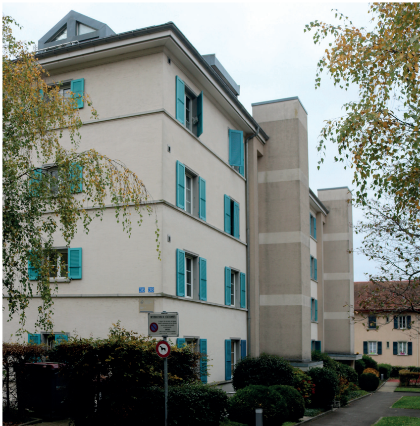
Fig. 35 Avenue Frédéric-César-de-la-Harpe 36-50, Frédéric Gilliard Façade «arrière» avec les ascenseurs ajoutés
