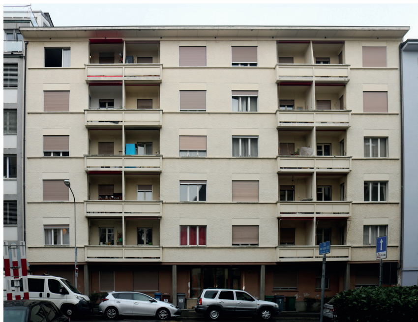
Fig. 32 Avenue Floréal 5, Paul Dumarthey Façade sur rue
