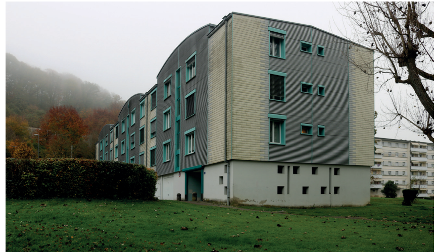
Fig. 24 Avenue d'Aoste 1-5, W. Vetter et J.P. Vouga, rénové par R. Knecht Vue en perspective depuis la façade pignon
