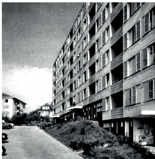
Fig. 7 Photographie de la façade Ouest originelle de W. Vetter et J.P. Vouga Photographie par la revue «Habitation» Parue dans le cahier n°11, novembre 1960
