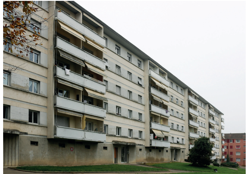
Fig. 21 Avenue d'Aoste 1-5, W. Vetter et J.P. Vouga, rénové par R. Knecht Vue en perspective depuis la façade pignon
