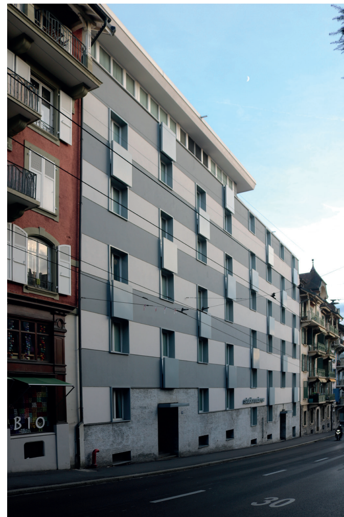
Fig. 9 Immeuble Rue du Valentin 5 Architecte Roland Willomet
