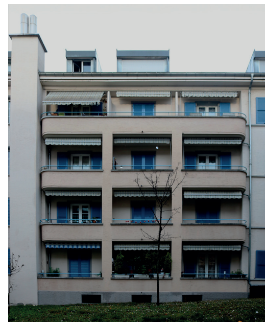
Fig. 37 Avenue Frédéric-César-de-la-Harpe 36-50, Frédéric Gilliard Détail des loggias de la façade Sud-Est
