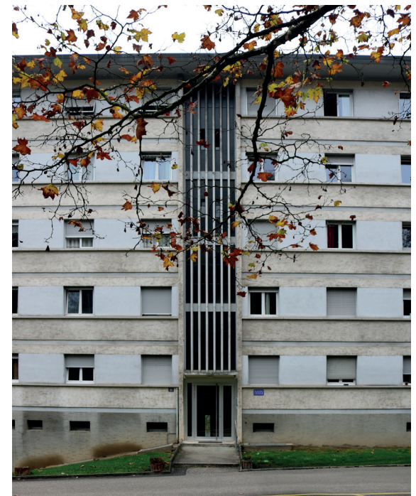
Fig. 22 Chemin de la Forêt 1-5, W. Vetter et J.P. Vouga, rénové par R. Knecht Détail de la façade sur rue
