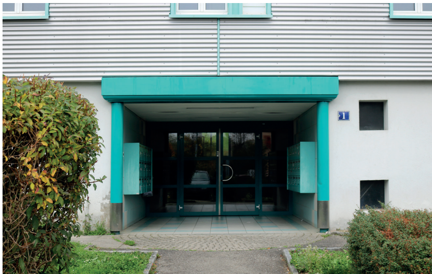
Fig. 23 Chemin de la Forêt 1-5, W. Vetter et J.P. Vouga, rénové par R. Knecht Détail de l'entrée
