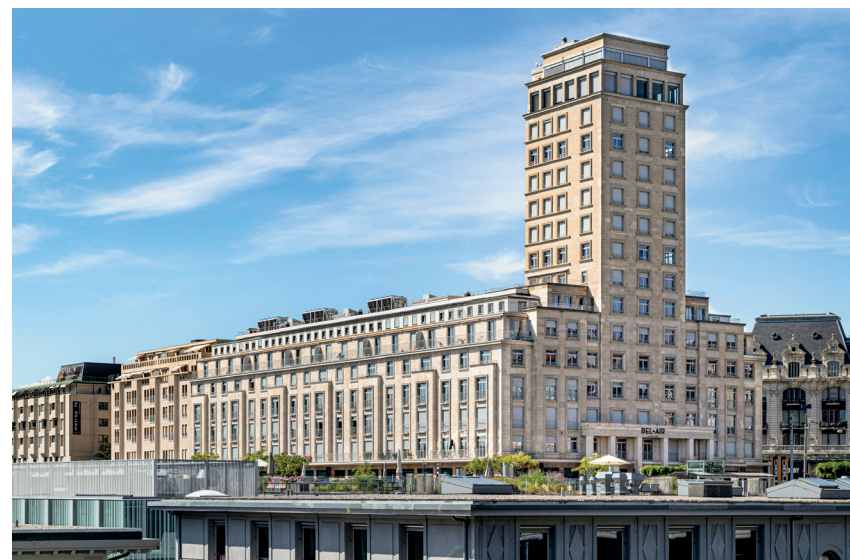
Fig. 30 Cité Bel-Air Métropole, Alphonse Laverrière Vue depuis le Grand Pont
