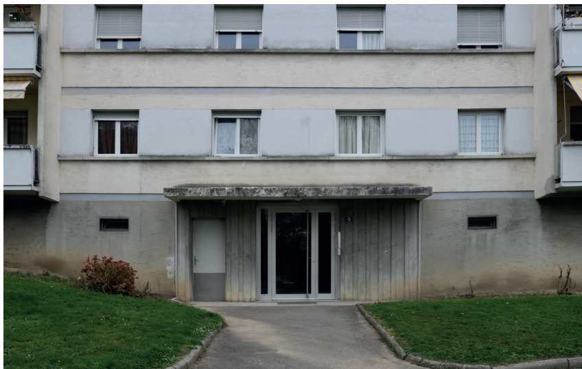
Fig. 20 Chemin de la Forêt 1-5, W. Vetter et J.P. Vouga, rénové par R. Knecht Détail de l'entrée
