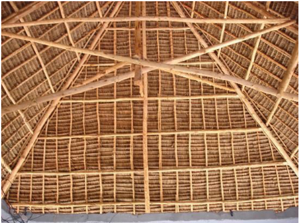
Structure de soutien
