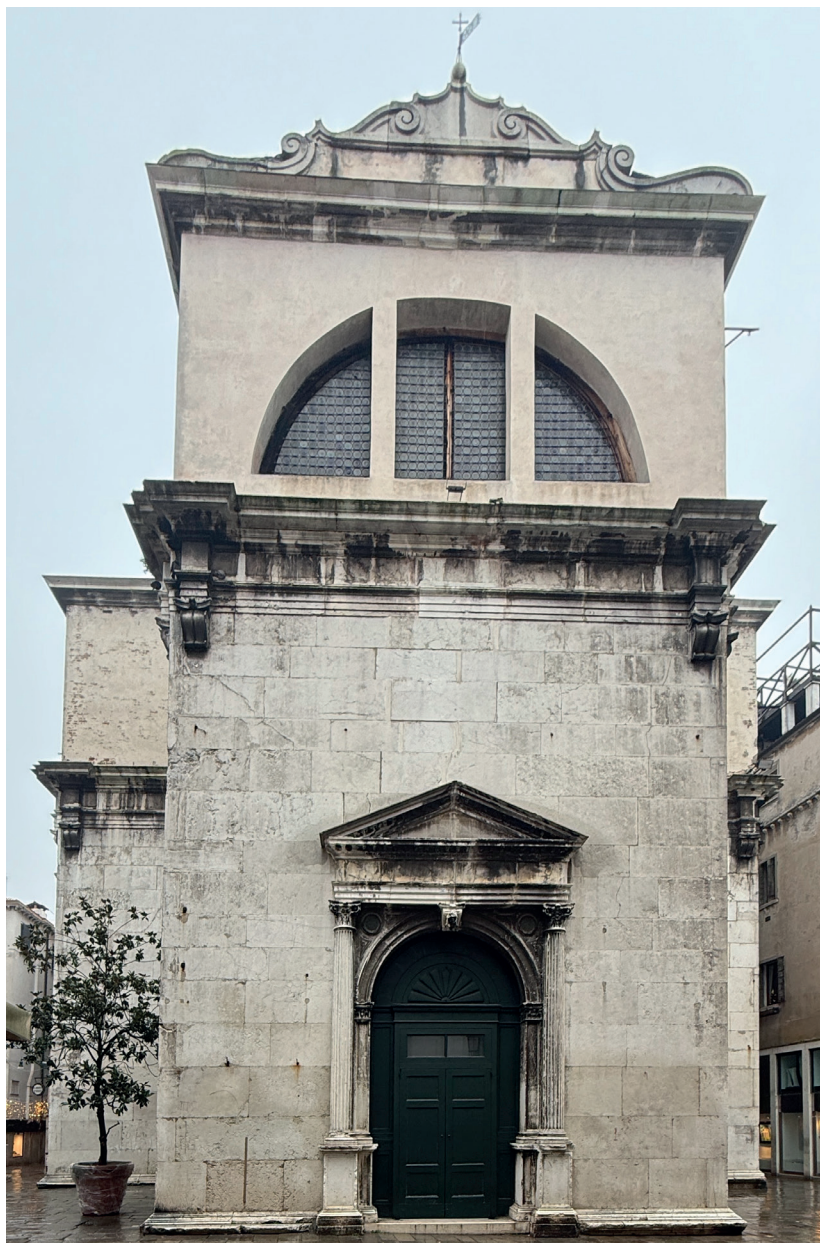
Fig. 52: Façade de l'église sur le campo
