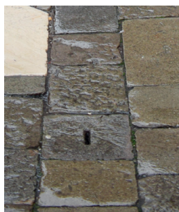
Fig 26: pilella, trou pour acheminement de l'eau
