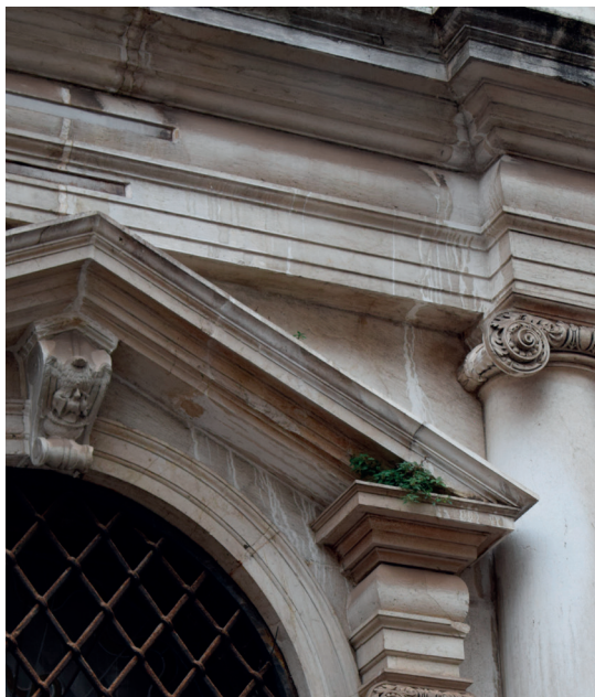
Fig. 63: Détail de façade
