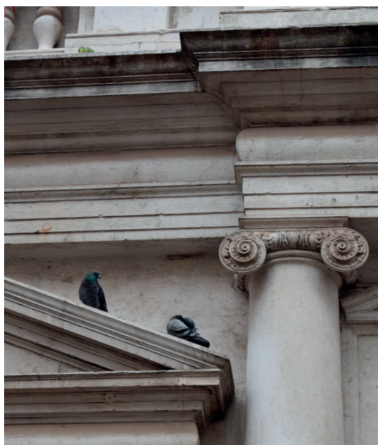
Fig. 61: Détail de façade
