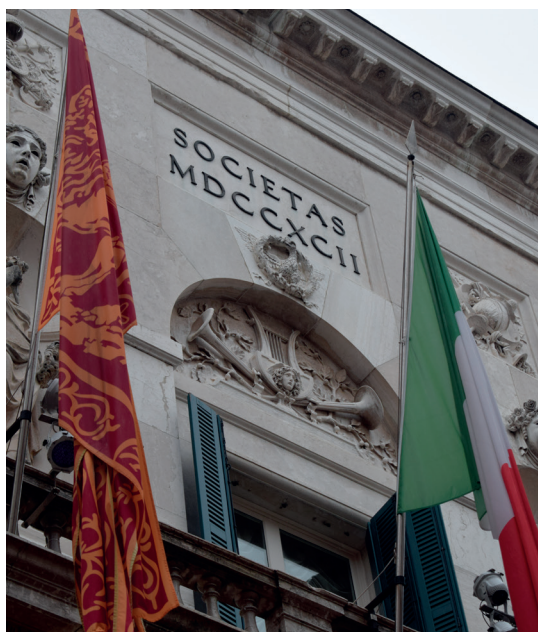
Fig. 43: Détail de façade
