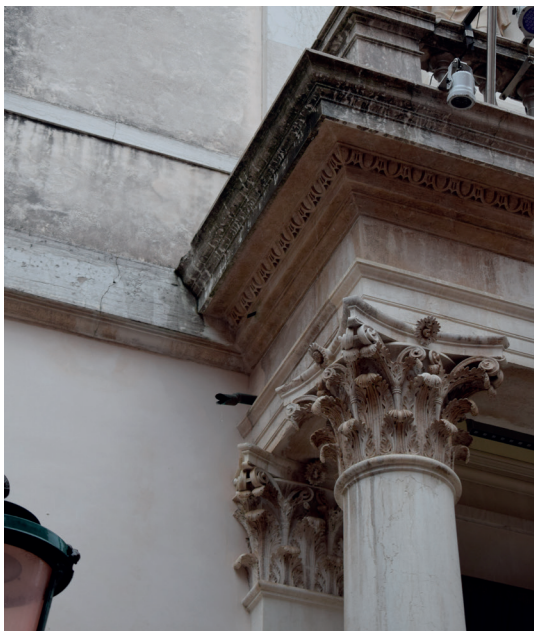
Fig. 40: Détail de façade
