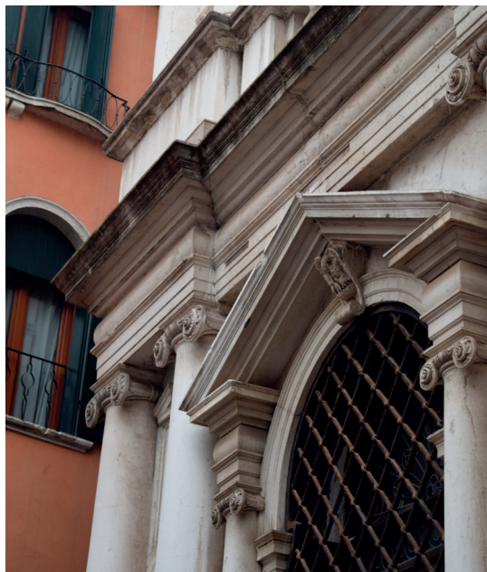
Fig. 62: Détail de façade
