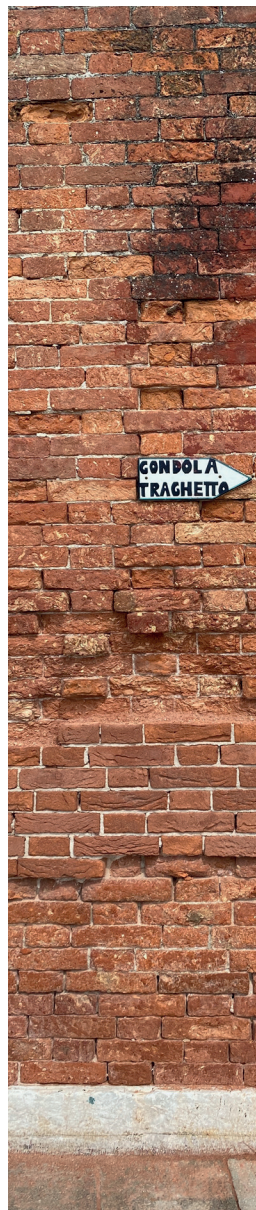
Fig 15: Mur en briques le long d'une fondamenta
