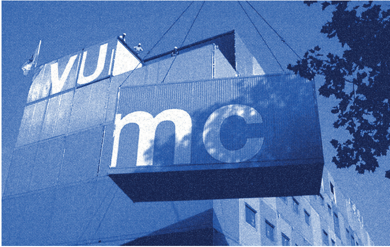
Fig. 32 Construction du Cancer Center conçu par MVRDV, 2005
