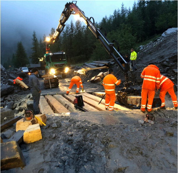
5 Fig. 15 ↑ Georges A. "Quel avenir pour la route Itravers-Vercorin ". Réponse du parlement en date du 09.08.2024 Travaux sur un pont fusible ©Frédéric Moulin, Le Nouvelliste
