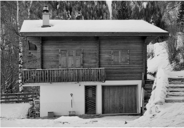
Fig. 70 ↑ Stationnement individuel inclus dans le corps bâti © Gautier Pierrat
