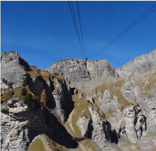
Fig.21 ↑ Fig. 22 ↑ Travaux de réparation à la suite des intempéries de l'été 2024, sur la ligne Viège-Zermatt ©Matterhorn-Gotthard-Bahn Téléphérique de la Gemmi surplombant des zones instables ©Artsinol, remontees-mecaniques.net
