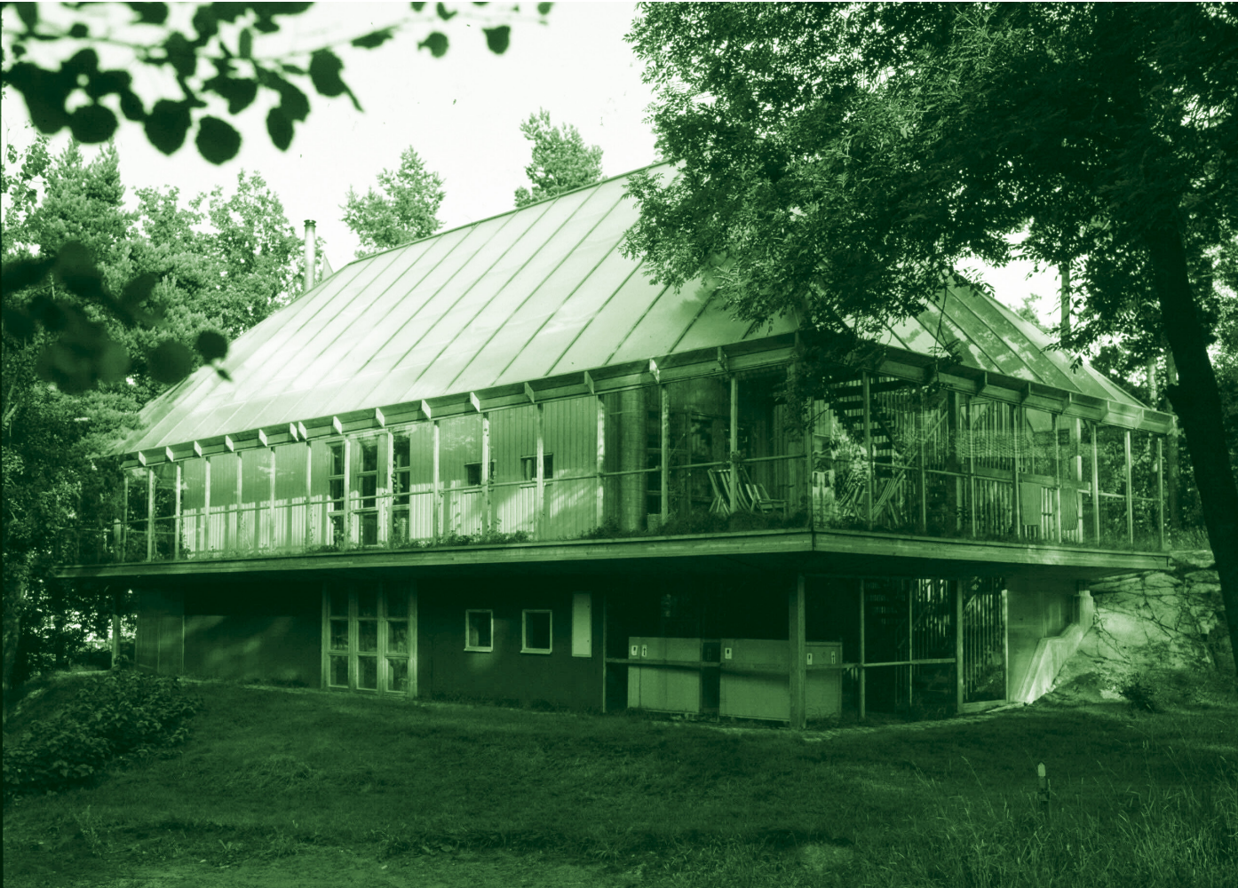
Fig. 6: Exterior view of the Naturhus (Source: Fredriksson M., Warne B., På akacians villkor (Sweden: Warne Förlag, 1993)
