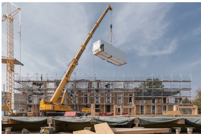
Acau architecture, Préfabrication des modules
