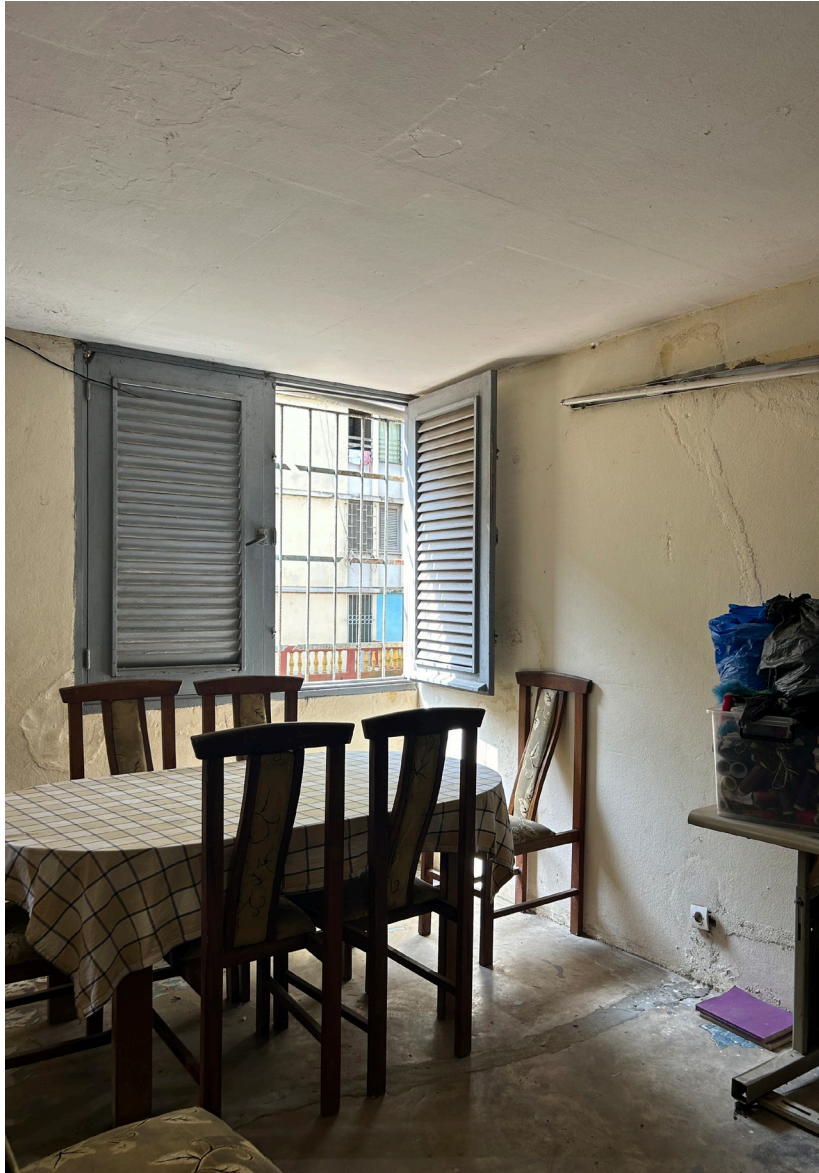
Appartement de Stéphane. 220 logements, Adjamé
