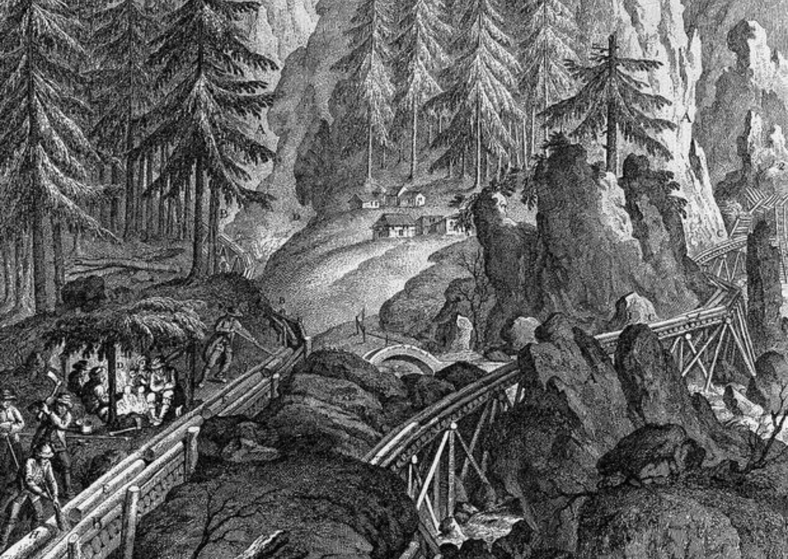
Figure 1 Glissoir à bois du XVIIIe siècle, nommé sovenda au Tessin, utilisé pour le transport du bois dans toute la Suisse
