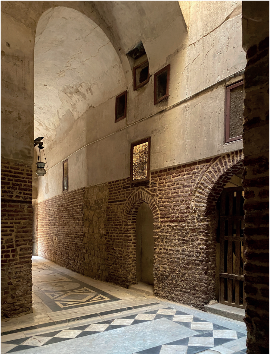
Figure 21 : Couloir d'entrée, khanqah Baybars el-Gashankir
