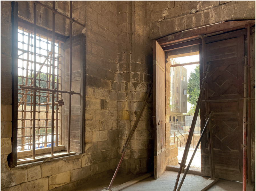
Figure 19 : Vestibule d'entrée, khanqah Faraj Ibn Barquq
