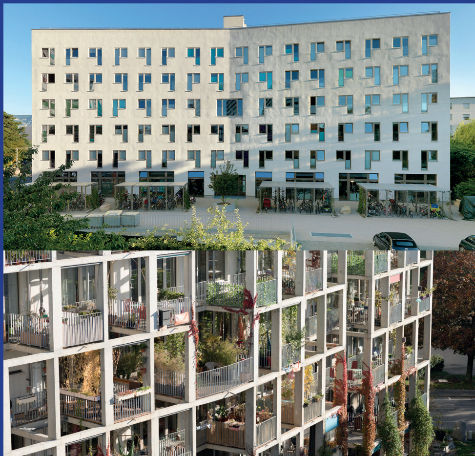
Fig.1 Immeuble coopératif rue Soubeyran, Genève
