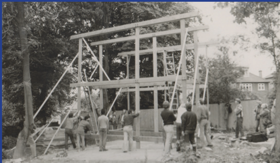
Fig.b3 Dressage collectif des cadres en bois utilisés dans la « Méthode Segal »
