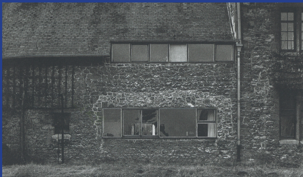
Fig.14 Rénovation des ouvertures, Maredsous
