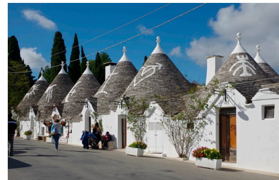
Figure 21 : Façades extérieures Trulli
