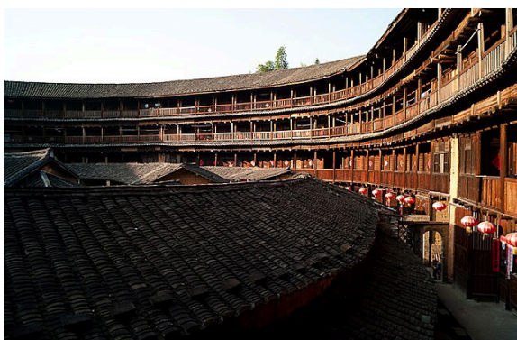
Figure 30 : Cour intérieure Tulou
