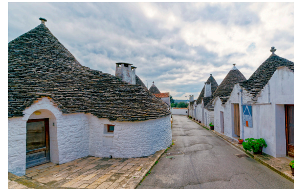
Figure 20 : Façades extérieures Trulli
