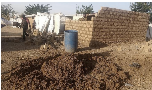
Fig 14: construction d'un abri en bloc de terre, 2022
