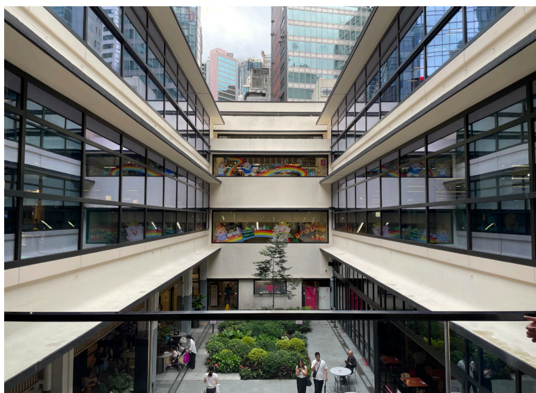
Fig 5.10 Nouveaux vitrages sur façades intérieures du bâtiment de Central Market
