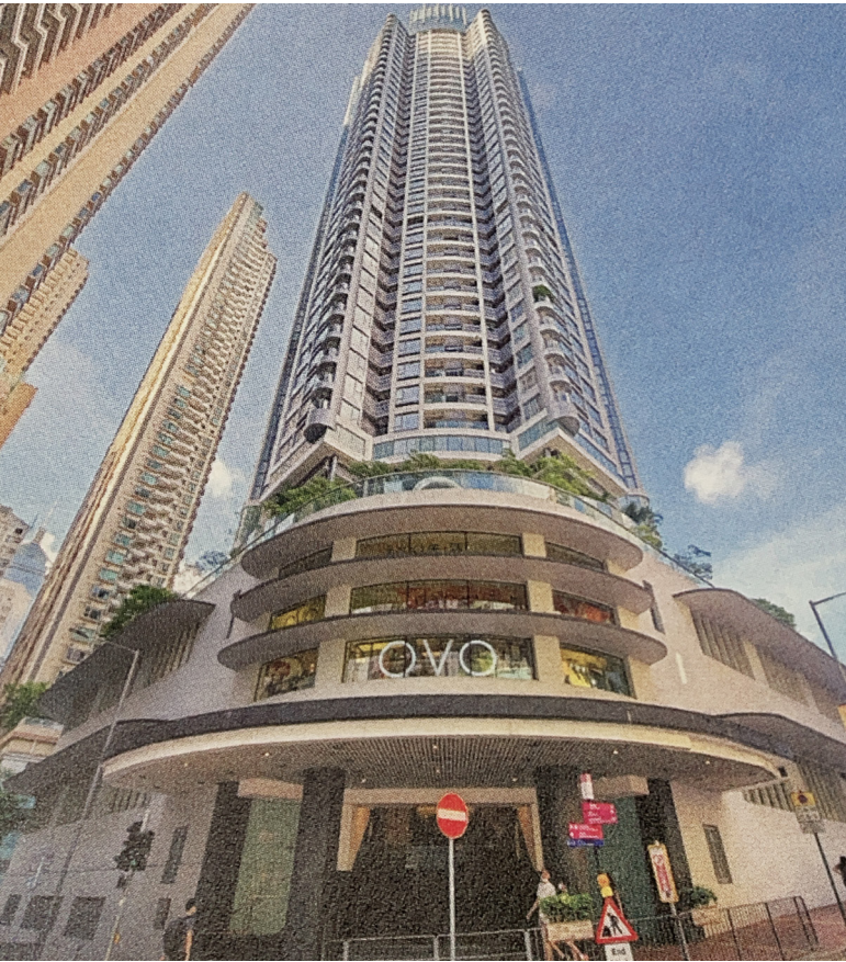
Fig 2.1.10 Une tour résidentielle se construit sur l'ancien Wan Chai Market. Source: Chung Man Carmen Tsui, 香港街市：日常建築裏的城市脈絡 (1842-1981) (Everyday Architecture in Context : Public Markets in Hong Kong (1842-1981)), Hong Kong: The Chinese University of Hong Kong Press, 2022, 155
